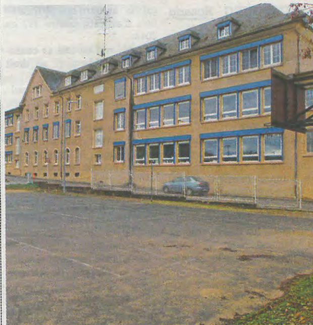
L'unité de sécurité de Dreiborn pourra accueillir jusqu'à 12 mineurs.
